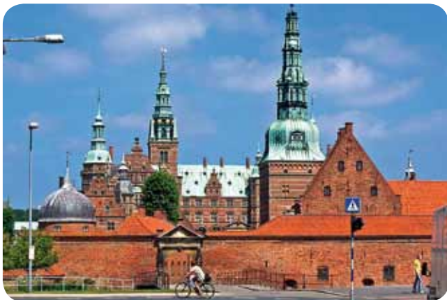
Schloss Frederiksborg ist das größte Renaissanceschloss Nordeuropas und befindet sich auf drei Inseln inmitten des Frederiksborgsees.
